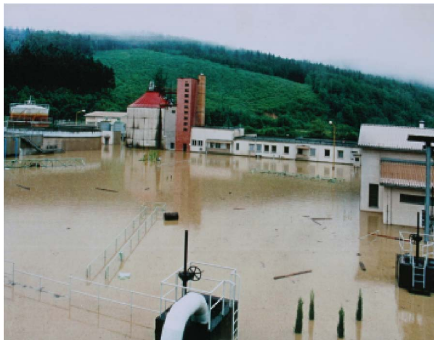
Zaplavená čistírna odpadních vod ve Vsetíně 7. července 1997. Většina čistíren odpadních vod byla zaplavena povodňovou vlnou, a tak mnoho dní neplnila svoji funkci. (Foto K. Pavelka)
