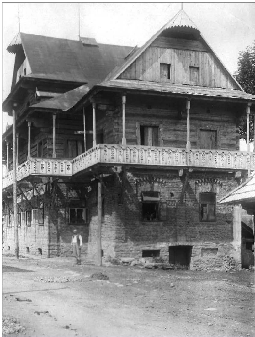
Usedlost J. O. Vraneckého st. – hrubá stavba s nedokončeným roubeným patrem (asi 1924) (Fotoarchiv MuRV Vsetín)
