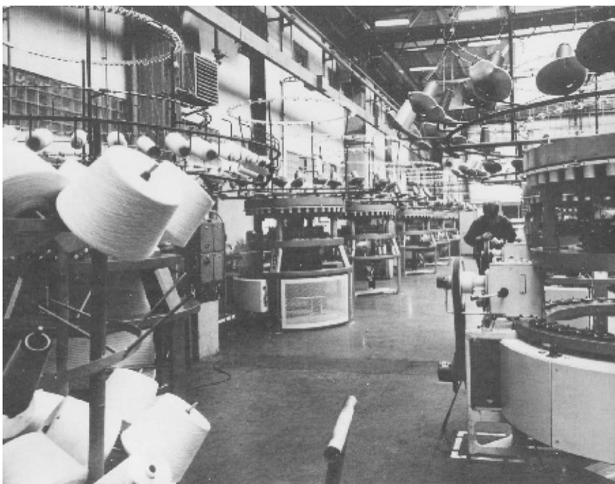
■ Zbrojovka Vsetín, provoz 700, hala M 1: montáž pletacích strojů (1978) (Fotoarchiv MuRV, foto M. Langer)
