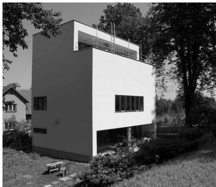
Funkcionalistická vila arch. Josefa Místeckého v Poličné; autorem rekonstrukce Ing. arch. Zdeněk Trefil (Foto M. Ošťádal)
