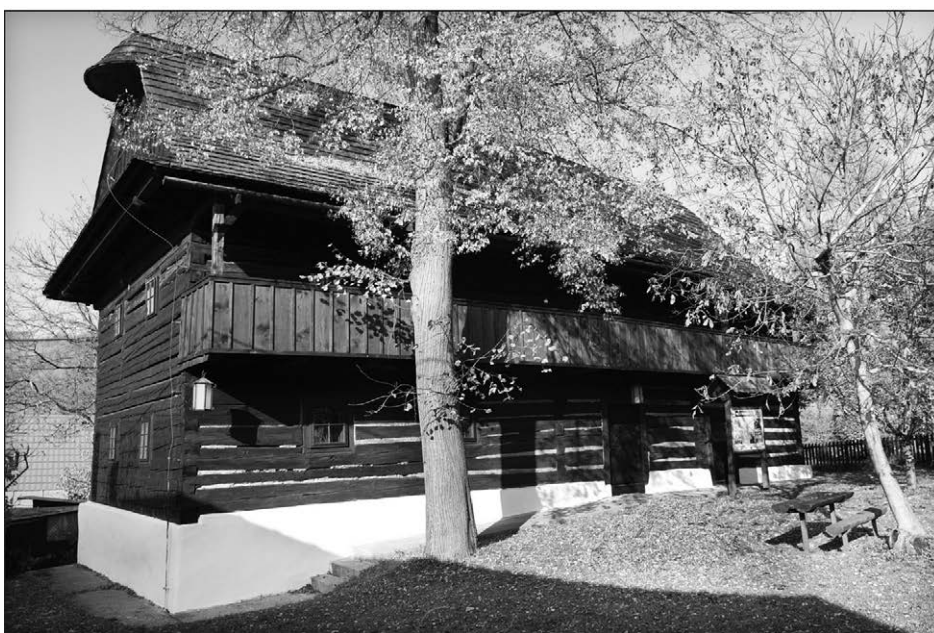
Fojtství po rekonstrukci
