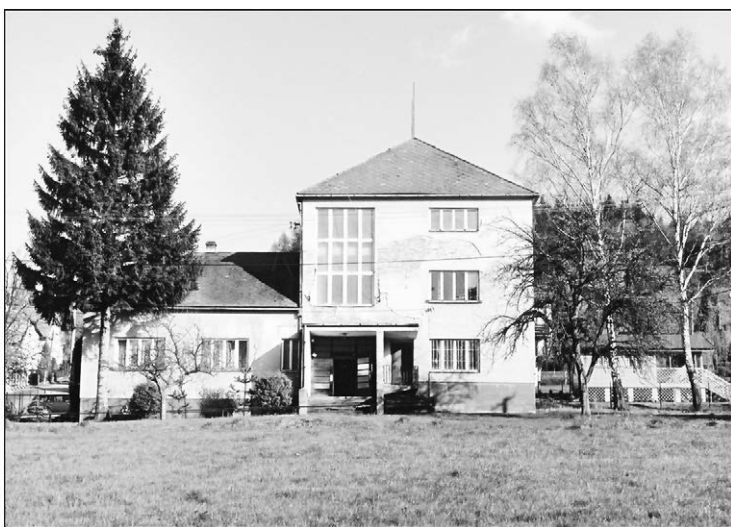
Budova Základní školy v Brňově, postavená v letech 1938–1940 dle plánů Bohumíra Kupky, vlevo byt učitele Emila Švejdy
