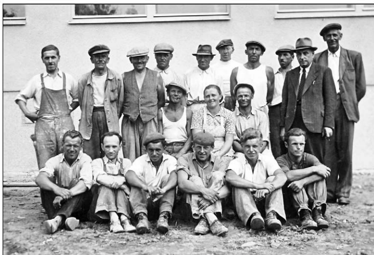
Stavitel Alois Sedlár (druhý zprava) a polír Rusek (zcela vpravo) se svými stavebními dělníky před budovou Základní školy v Poličné v roce 1950
