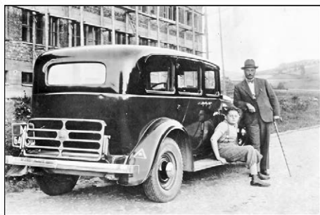
Stavitel Sedlár se svým synem Milanem před staveniš- tém školy ve Valašské Bystřici v srpnu roku 1934. Alois Sedlár vlastnil několik vozů, k nejoblíbenějším však patřil tento Citroën. Foto sbírka rodiny Leinfellnerovy
