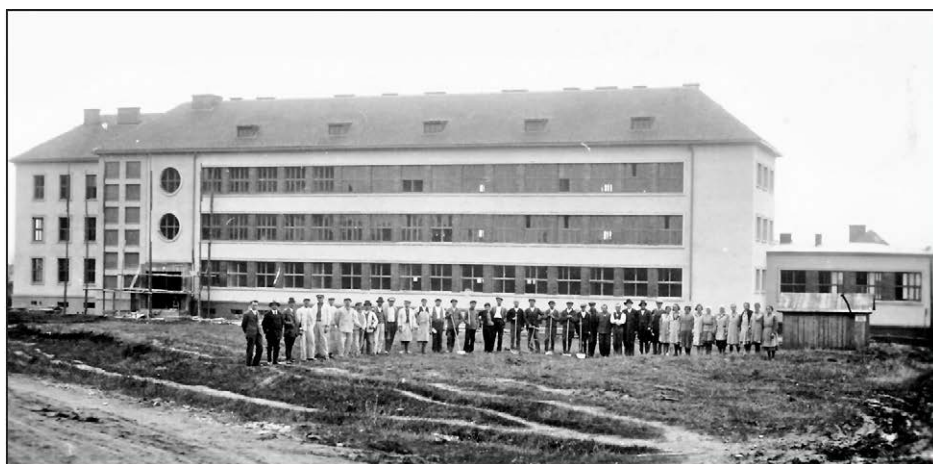
V roce 1933 se Antonín Sedlár podílel na stavbě učitelského ústavu ve Valašském Meziříčí podle plánů Milosla- va Lamla. Kromě Sedláře se vybudování učitelského ústavu (dnešní ZŠ Šafaříkova) zúčastnily stavitelské firmy J. Demla a V. Brdy z Valašského Meziříčí. Foto sbírka Jindřicha Zetě
