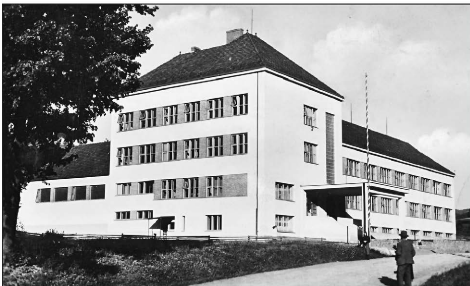
Budovu školy ve Valašské Bystřici stavěla firma Aloise Sedláře dle plánů Bohumíra Kupky v letech 1931–1934. Základní kámen byl slavnostně položen 12. 7. 1931, dne 26. 10. 1934 byla škola zkolaudována, 28. 10. 1934 slav- nostně vysvěcena a otevřena. Foto sbírka Antonína Žlebka
