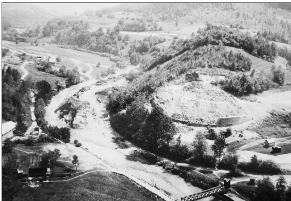
Údolí potoka Bystřičky v době zahájení přípravných stavebních prací na přehradě
