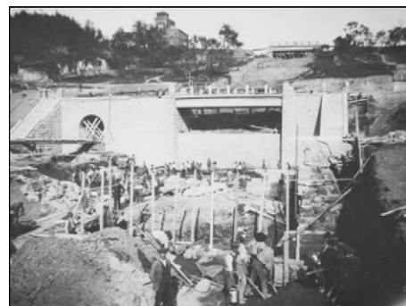
Staveniště přehrad pod hrází - budování kaskád a vypouštěcího tunelu
