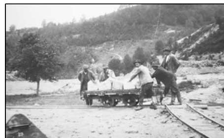
Doprava materiálu na staveniště - v době výstavby přehrad byla zřízena úzkorozchodná trať z vlakové stanice Rouštky (dnes zastávka Bystřička).
