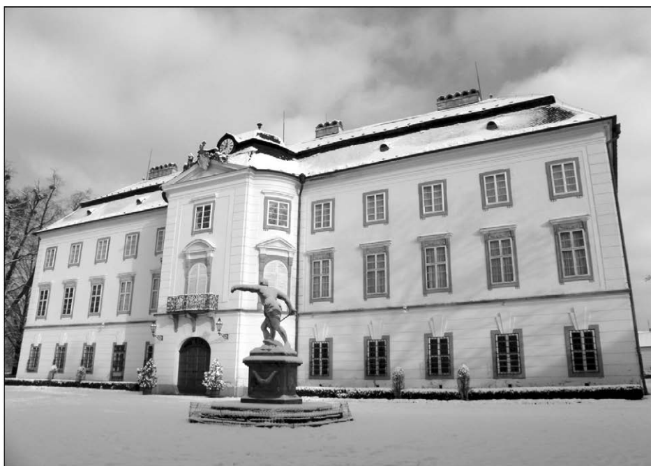
Pohled na západní křídlo zámku Vizovice
