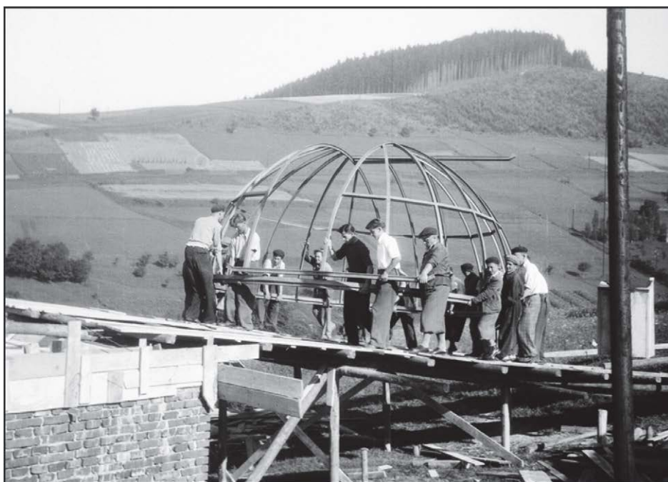
Instalace těžké konstrukce kopule v létě roku 1949 byla náročnou ruční prací. Foto archiv hvězdárny
