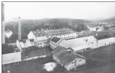
Továrna ve Velkých Uhercích koncem dvacátých let 20. století, tedy nedlouho před zastavením provozu MZA Třebíč
