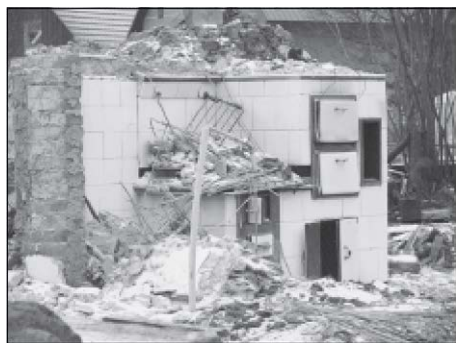
Dům čp. 72 před dokončením demolice, srdcem každého domu byla kuchyně. Foto R. Sobotka
