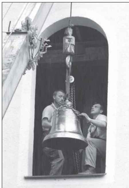
Instalace zvonu 11. 8. 2007 v Růžďce Foto J. Vetchý
