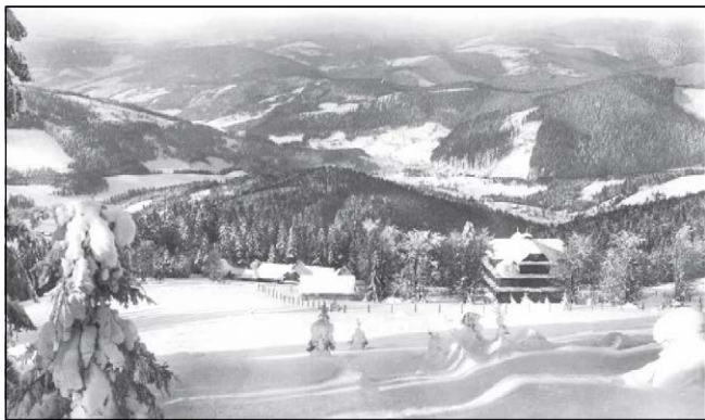
Útulna na Velkém Javorníku (1 071 m n.m.) s výhledem do údolí Podtáté ve Velkých Karlovicích
