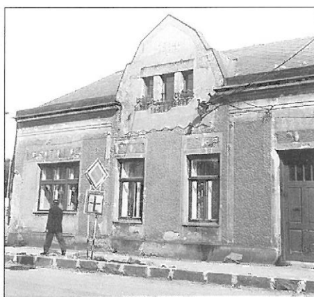
Dům s barvírnou ve Štěpánské ul. č. 375. Původně vpravo průjezd, vlevo obchod
