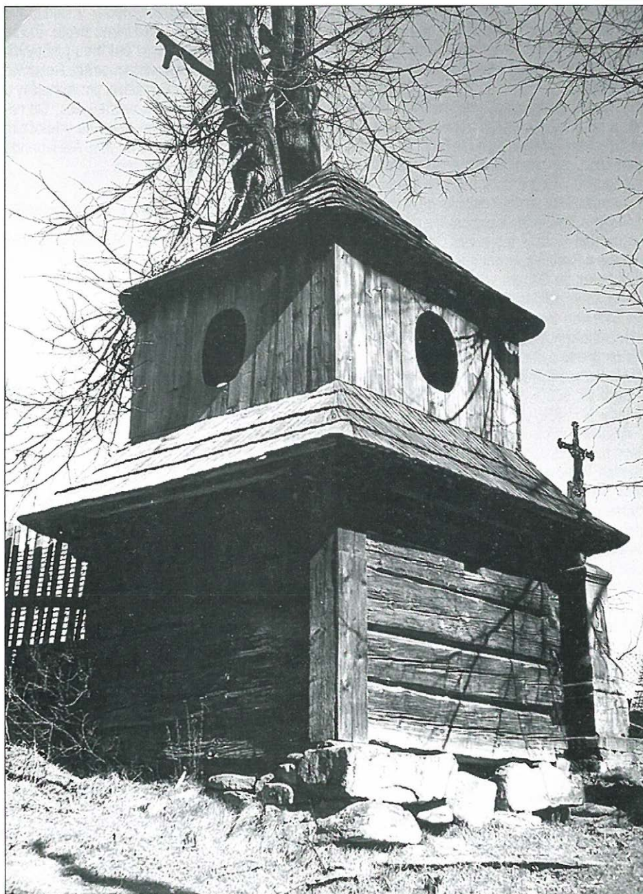
Zvonice s křížem ve Střelné
