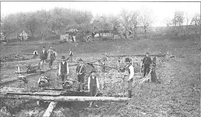
Výkop základů štol na jaře r. 1908
