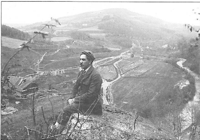
Údolí Bystřičky před stavbou přehrady, vpravo původní koryto potoka
