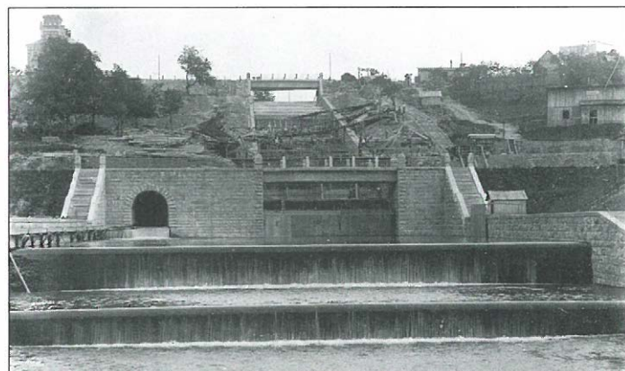
Přebytečná voda z nádrže přepadává přes boční bezpečnostní přepad postavený ve vzdálenosti 150 m od hráze. Povodňová voda padá dolů přes dvacet kaskád o šířce 14 m do sběrného bazénu širokého 35 m a hlubokého 2, 30 m, kde se uklidňuje a odkud pak ještě přes dva betonové stupně teče do starého koryta řeky Bystřičky
