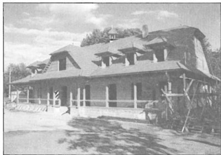
Na místě staré budovy vyrůstá nový restaurační objekt - stav září 2000 Foto: M. Stibor
