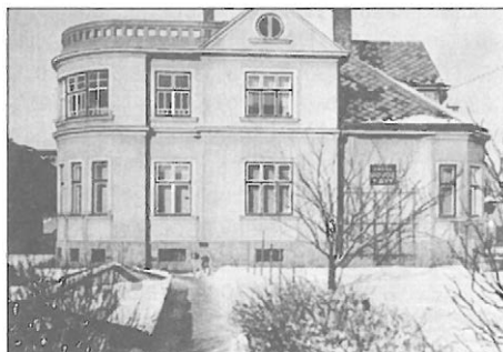
První budova balírny a pražírny ve Valašském Meziříčí, kde v podkroví měl otec ateliér.
